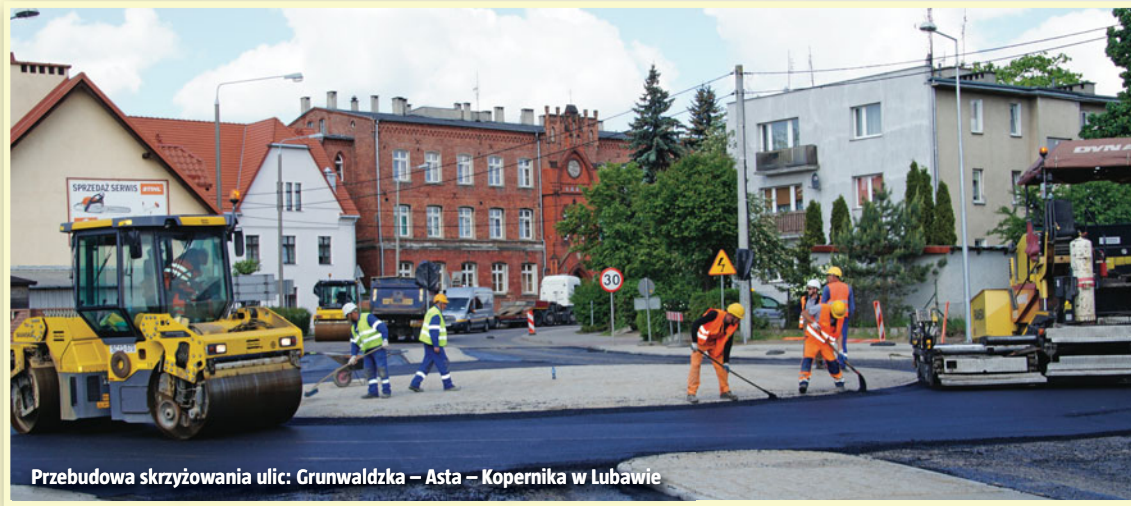
Przebudowa skrzyżowania ulic: Grunwaldzka – Asta – Kopernika w Lubawie
